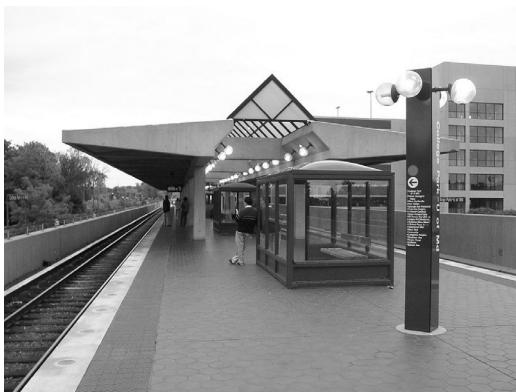
I-8. Stacja College Park – University of Maryland. Dach dwuwspornikowy o głębokim wysięgu nad tory
