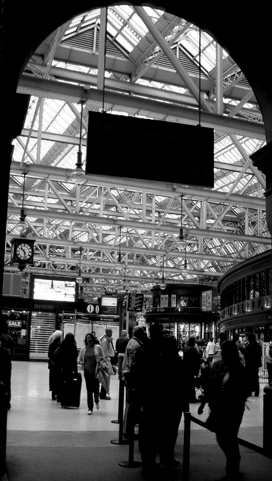
I-1. Dworzec Glasgow Central – hala z 1879 r. widoczna od wejścia fot. autora, 2011
