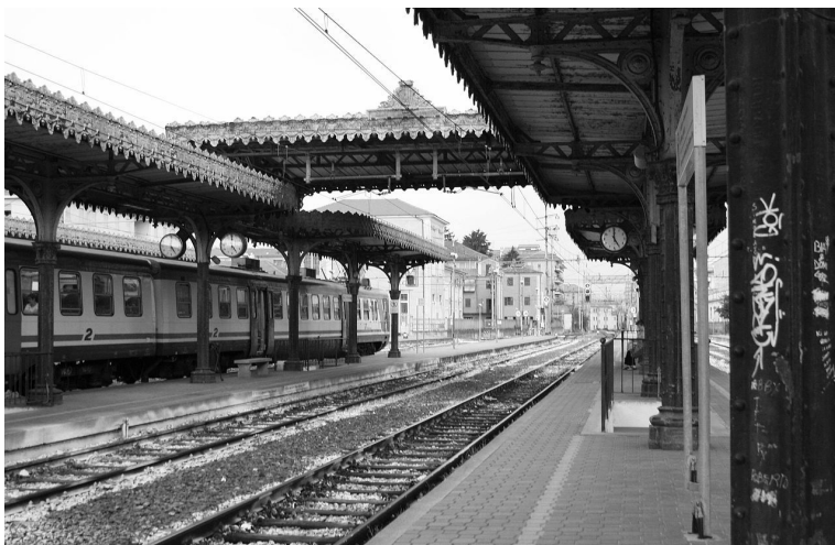
I-11. Dworzec Acqui Terme. Zadaszenie nad nieistniejącym przejściem przez tory, wyjątkowo ozdobne
