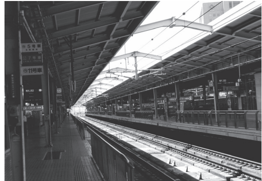
I-4. Dworzec Shin-Ōsaka w Osace. Wiaty połączone w jedną sztywną konstrukcję. Hala czy wiaty? fot. autora, 2005,
