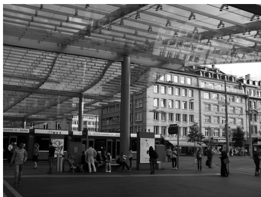
I-16. Berno. Zadaszenie przystanków Bahnhofplatz
