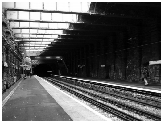
I-7. Stacja Green Lane w Birkenhead. Konstrukcja nad torami służy jako rozpory u szczytu murów oporowych oraz, częściowo, dla nadbudowy
