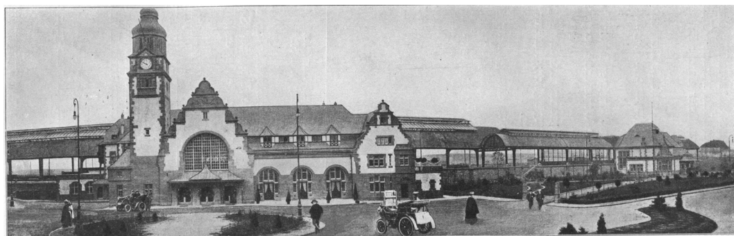
I-17. Dworzec Bad Homburg v. d. Höhe (1907) – widok frontu. Po prawej „pawilon księżycy” z osobną nawą hali peronowej Schmitt, Empfangsgebäude... , 1911
