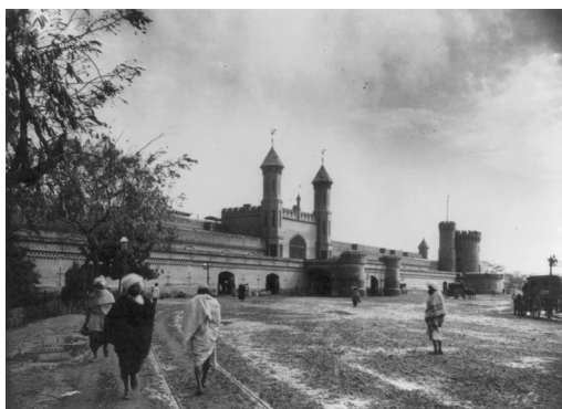
I-13. Dworzec Lahore. „Twierdza kolejowa” z halą w obrębie budynku
