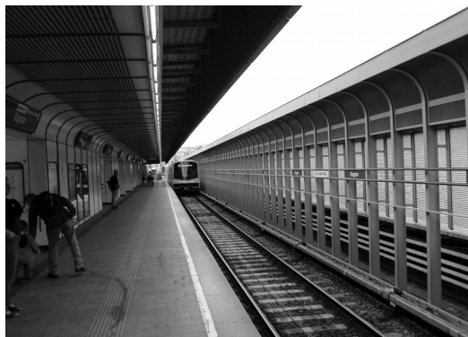
I-9. Wiedeń, stacja metra Kagran – wiata ciągła z zewnętrznymi ścianami osłonowymi
